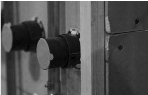
图 5.2.3 架空墙面的螺栓和管线示意图
